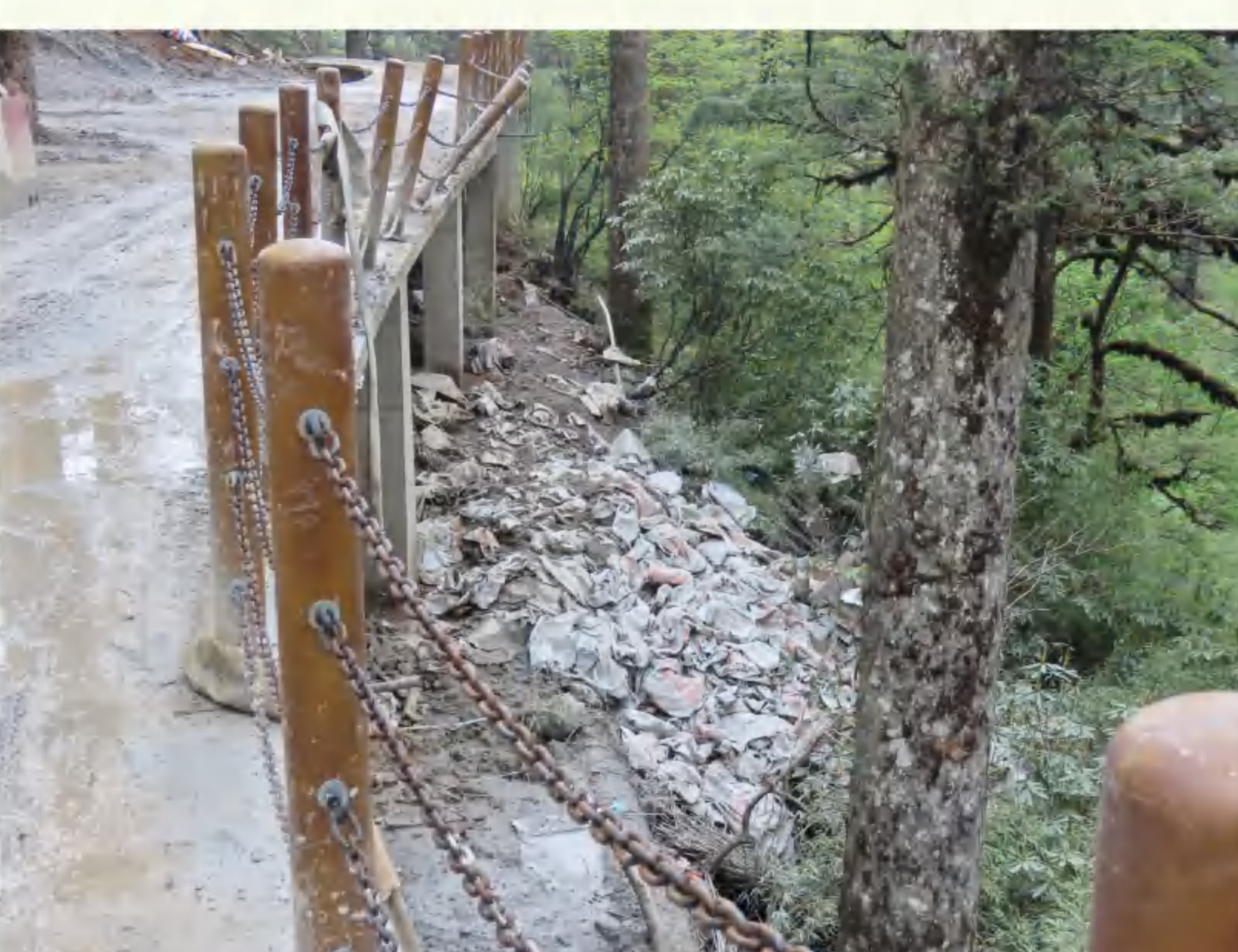
建筑垃圾, 瓦屋山
